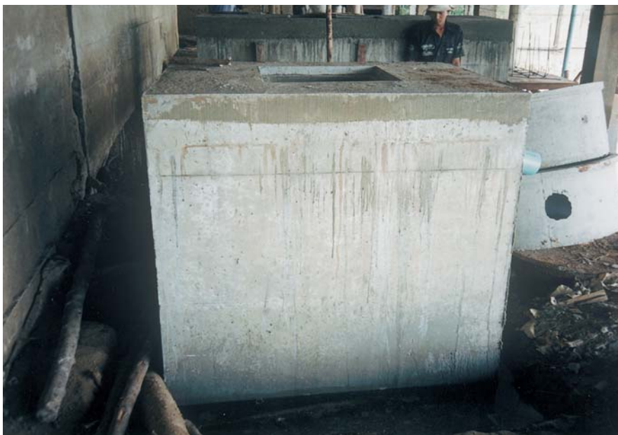
ประกอบแบบและหล่อคอนกรีต
