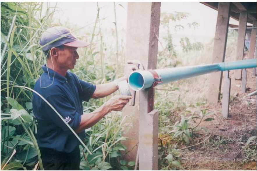
การประสานท่อส้วมและท่อน้ำทิ้งจากอาคารไปยังระบบบำบัดฯ
